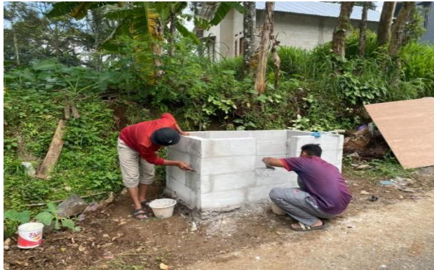
Gambar 1. Proses pembuatan bak sampah
