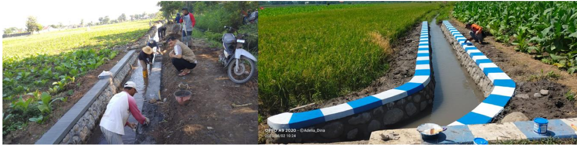
Gambar 5. Obyek Pembangunan Fisik yang diawasi dan dievaluasi; Pembangunan Saluran Irigasi Sawah
