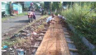
Proses penutupan pengecoran sampai mengering
