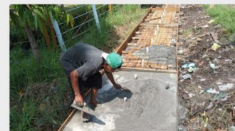
Proses pemasangan kawat penyangga untuk pengecoran
